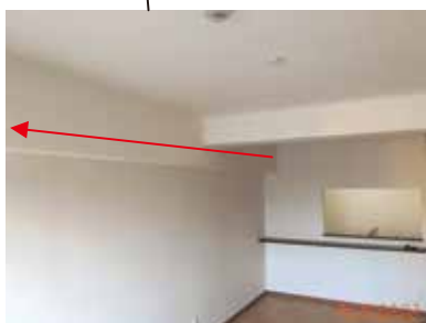
ダクトスペース 壁に沿ってダクトを通す様に箱を造りました。
