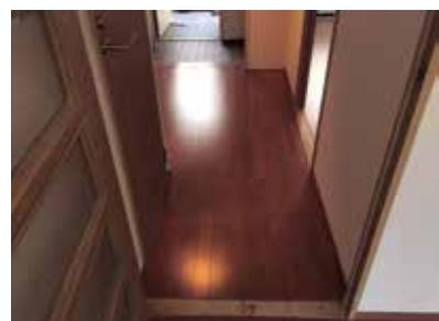
床フロアは全面張替え、壁面石膏ボードも水を吸っている部分は貼替えてクロス工事で完了です。
