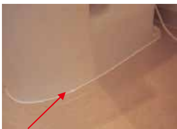
床シートくりぬき施工 (便器脱着なし) 便器際は コーキング処理
