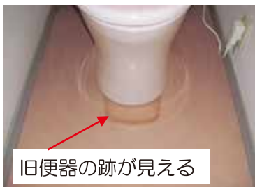
床シートくりぬき施工 (便器脱着なし) 便器際は コーキング処理
