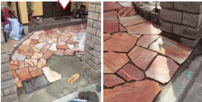
解体・石張り
