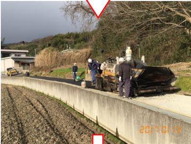
アスファルトは通常5センチの厚みを打ちます。ただし重要なのはアスファルトの下地、路盤工事と言いますが碎石を10センチ敷いて転圧で固めてから舗装です。路盤をきちんとしないとアスファルトは割れてしまいます。
