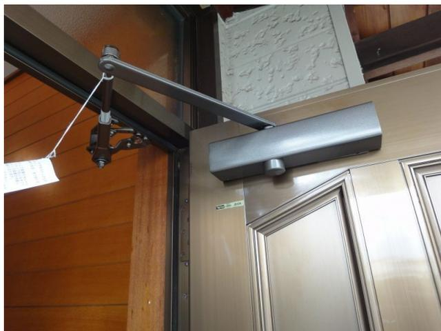
玄関ドア等の上の方についているこれがドアクローザーです。開き戸の閉まるスピードを調整してくれる機械で、これが壊れると閉まる時のブレーキが効かずガチャン!と閉まってしまいます。
