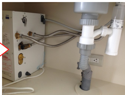
既設の排水管と接続
