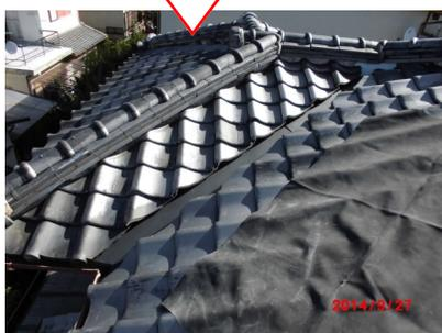
新しい谷板金は「ガルバリウム」という「アルミと亜鉛の合金」です。つまりアルミの特性で錆びにくいので、劣化により穴が開きにくい材料なんです。また「土ぶきの瓦屋根」は経年劣化で土が下にズレ落ち瓦もズレてしまいます…
