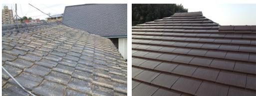
築20年以上の量産住宅に広く使われていました。文字通りセメントを成形して表面を塗装したものでカラーベストも同じ種類です。表面の塗装が剥げやすいのとセメントなので割れやヒビが出やすいですが、軽いのが特徴ですね。ちなみに強度を上げるためにアスベストを混ぜた瓦材もありました・・・
