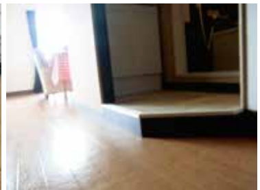
↑ 排水管の勾配を取る分洗面室の床を上げました。
