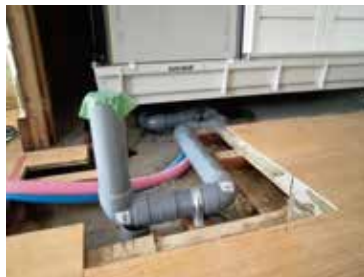
↑ 洗面台用の排水管を既存の浴室排水から分岐。
