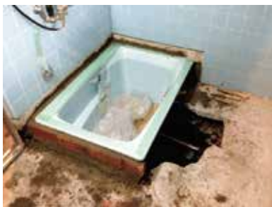
耐火煉瓦 浴槽回りと底の焚き床に施工
