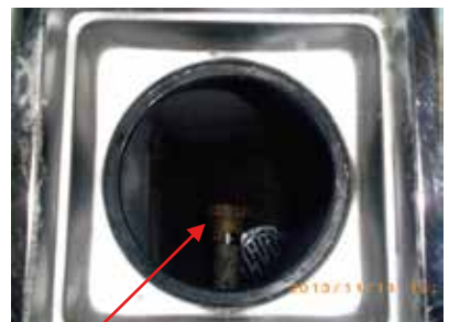
排水バルブ 排水口の蓋の中に、浴槽排水用の バルブがあります。
