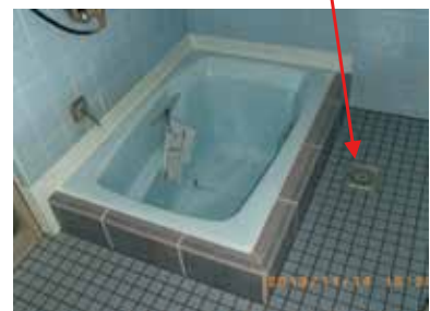
排水バルブ 排水口の蓋の中に、浴槽排水用の バルブがあります。
