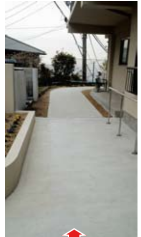
工事後 門扉側から
