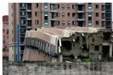
↑強度不足で倒壊（中国）
