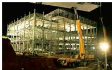
↑夜間まで続く突貫工事
