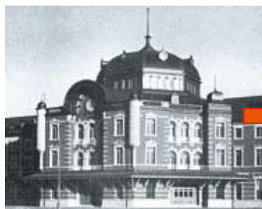
1914年(大正3年) 創建 鉄骨レンガ造 3階建 ドーム屋根
