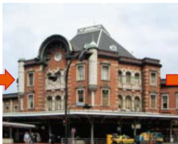
1945年(昭和20年) 改修工事 大空襲で屋根が焼失 2階建 角屋根(寄棟)
