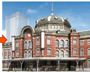
2012年(平成24年) 復元免震工事 創建当時を復元 3階建・地下2階 ドーム屋根
