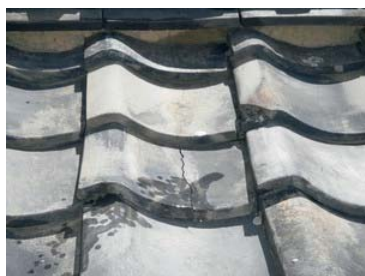
屋根瓦ひび割れ点検
