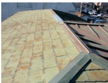
屋根塗装劣化点検
