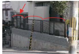
アルミフェンス、端の1枚（赤矢印）は1mにカットしてピッタリサイズに
