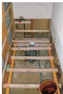
④根太交換 大引には 防腐塗装
