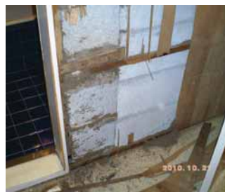
②解体・床壁材木入替え
