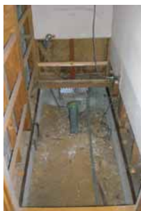
③床解体 根太が腐って るので交換
