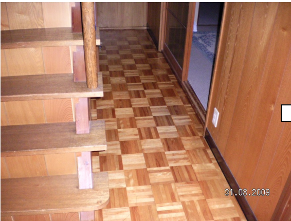
△ 階段廊下 工事前
