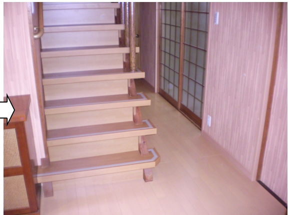
△ 工事後(リフォーム階段)
