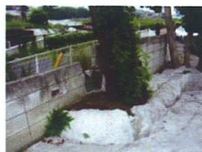
↑木の根が押しつけて塀が破壊！塀を強固なものにするか、木を植え替えるか？
