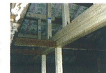
←鉄骨造 床下梁 この梁の切断は 強度に問題ない
