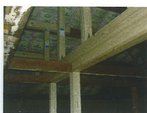
↑梁・束・柱追加補強
