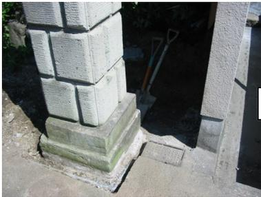
▲施工前（傾きによるひび割）
