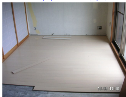
リフォーム中(フローリング貼り)
