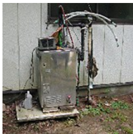
施工前は石油給湯器
