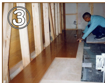
3 通常の張替え同様にフロア材を張っていきます。
