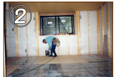
2 床暖房が不要な部分には、板材をはり床の水平を合わせます。
