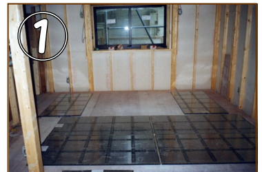
1 既存の床をめくり床暖房本体シートを敷きます。
