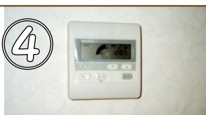
4 電気配線、コントローラー取り付けで完成。
