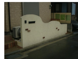
↑ 曲線塀・ポイントレンガ貼り ジョリパッド仕上げ
