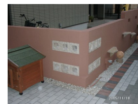
↑ 穴あきブロック
