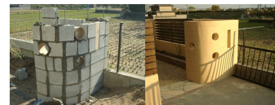
↑ 曲面塀・オリジナル丸開口
